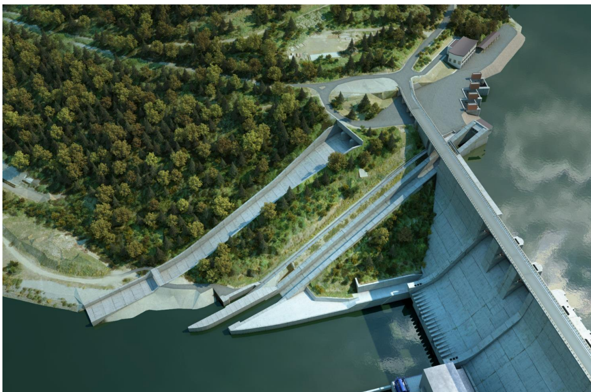
Nové pojistné zařízení na pravém břehu VD Orlík
